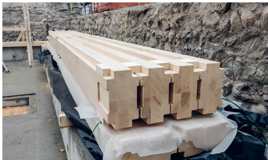
Der Querschnitt der bis zu acht Meter hohen Pfosten aus einheimischer Weisstanne zeigt die innere Struktur. Zum Schutz und aus gestalterischen Gründen sind die Kanten eingekerbt.
